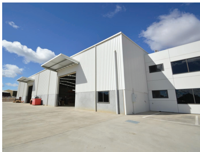
XÂY DỰNG NHÀ MÁY
