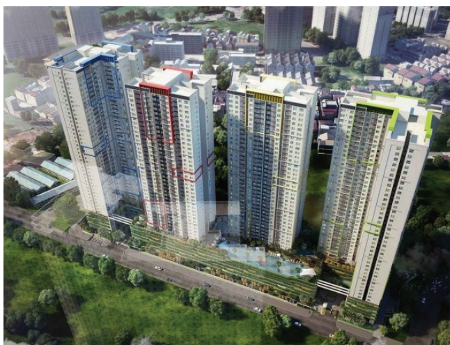
XÂY DỰNG CHUNG CƯ
