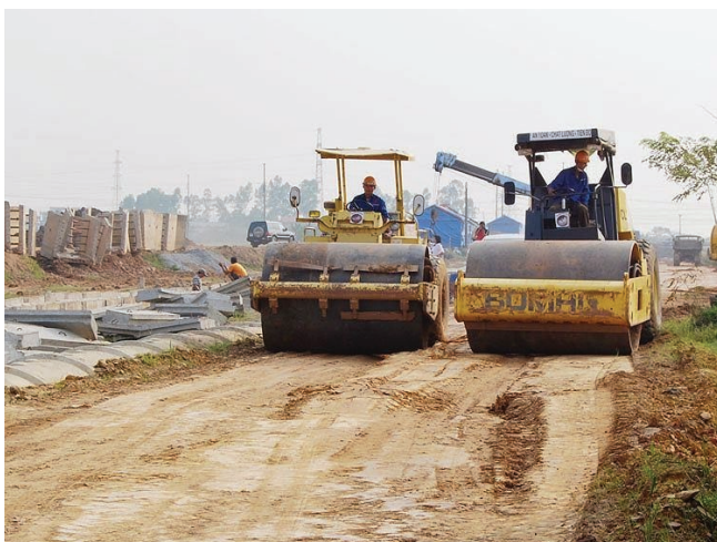
CÔNG TRÌNH HẠ TẦNG
