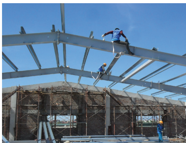
CÔNG TRÌNH NHÀ XƯỞNG
